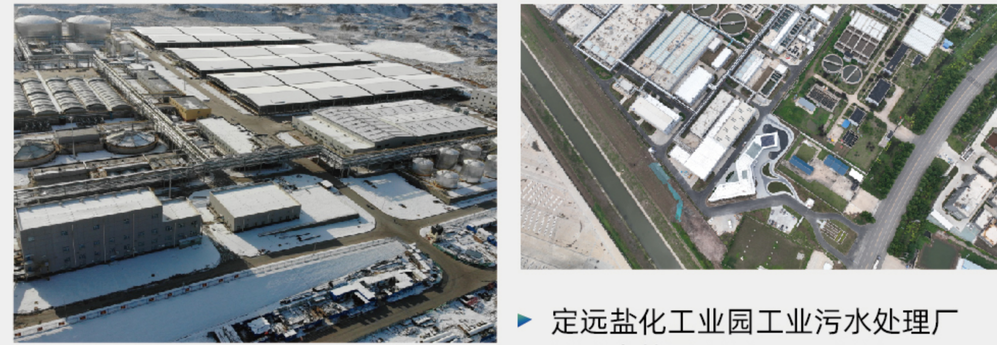
▶ 定远盐化工业园工业污水处理厂及配套管网项目EPC项目 (安徽省内第一个“化工园区高盐废水处理+尾水湿地净化”灰绿结合模式, 实现双达标的污水处理厂项目)
